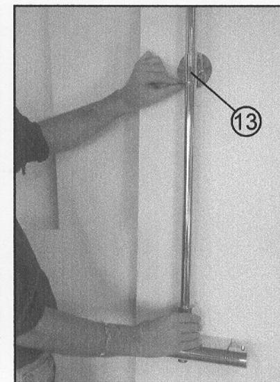
I Posizionare il supporto della colonna doccia 9, **perpendicolarmente** rispetto al centro del termostatico ad una distanza di 613 mm dalla base (vedi disegno pagina seguente), e fissarlo alla parete con il tassello e la vite 10 in dotazione (foro diametro 6 mm).
