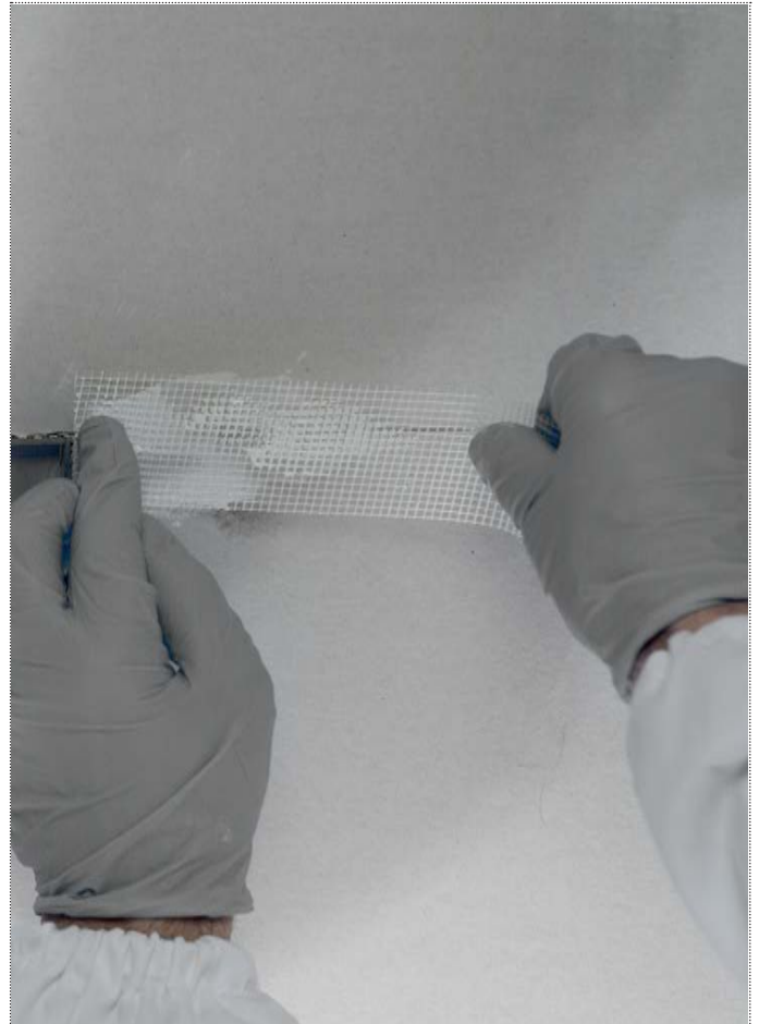
2_IT_Garzatura_EN_Mesh for plaster_FR_Gaze pour plâtre_ES_Gasa_DE_Armierungsgewebe_RU_Наклеиваем стыковочную ленту
