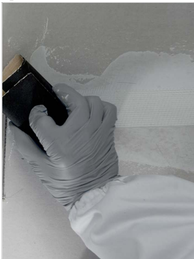
3_IT_Stuccatura_EN_GROUTING_FR_jointoiement_ES_Estucar_DE_Spachtelung_RU_Наносим шпаклевк
