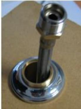
**8** Passer le flexible inox dans le coulant par le dessous (partie male vers le haut) et visser le flexible de douche sur le flexible inox.
