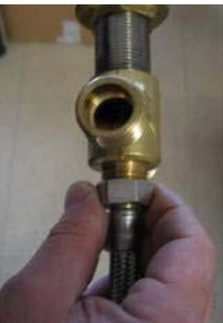
**13** Relier le flexible inox à la batterie bain ou inverseur ou mitigeur (arrivée d'eau de votre système).
